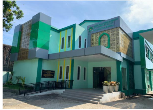
Gambar 1.6 Gedung Laboratorium dan Perpustakaan
